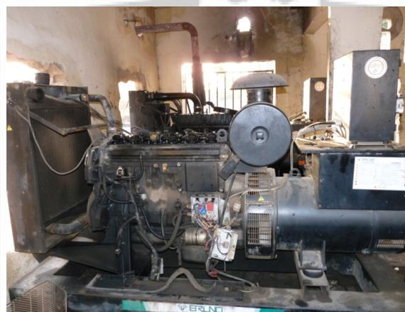
Fig. 2: Grupo electrógeno diesel
