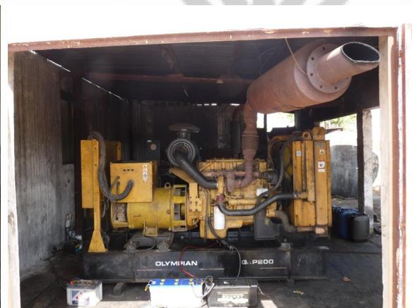
Fig. 8: Grupo electrógeno diesel
