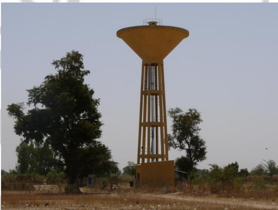
Fig. 13: Depósito de almacenamiento en altura para distribución por gravedad
